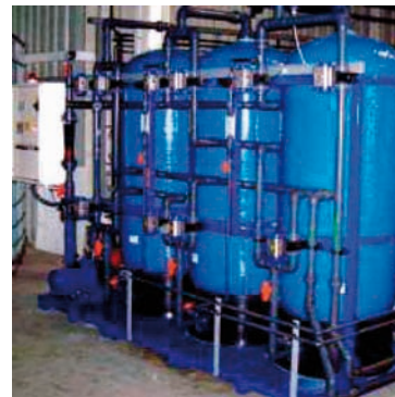
Desmineralizador IRA 36/750/3S (18.000 L/H)
